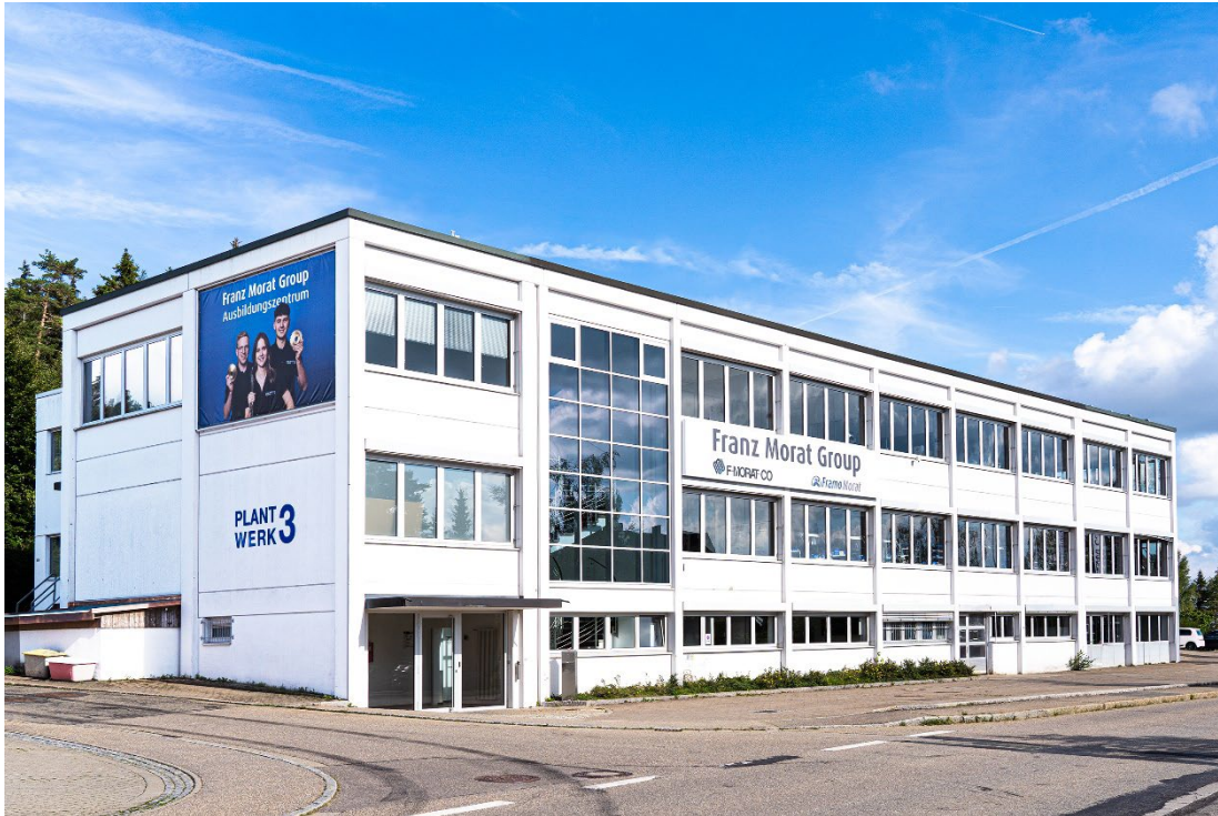
Werk 3 auf dem Höchst in Eisenbach beherbergt neben dem Technischen Service und der Montageabteilungen das neue Ausbildungszentrum. (Bildquelle: Franz Morat Group)
